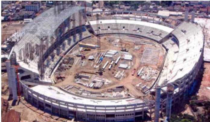
Engenheiro: Vista geral durante a construção
