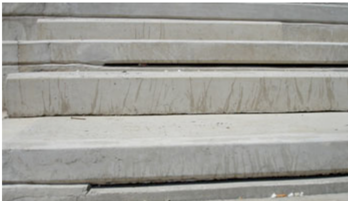
Detalhe das juntas a serem calafetadas
